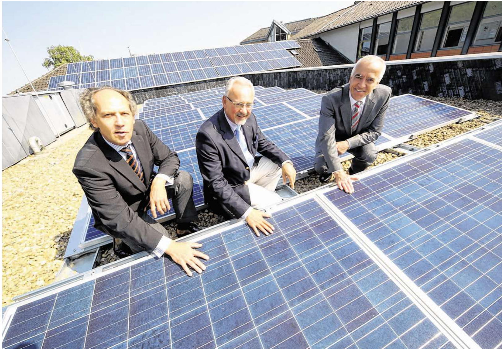
Photovoltaikanlage auf der Käthe-Kollwitz Schule: Dr. Peter Asmuth (Stawag), Helmut Etschenberg (Städteregionsrat) und Hans Pontzen (Schulleiter) weihten die Anlage ein. Foto: Andreas Steindl
